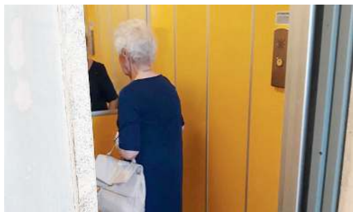
In via Del Sarto. L'ascensore finalmente funzionante
