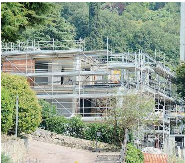
Lavori. La futura casa di Renga, ristrutturazione di un edificio esistente
