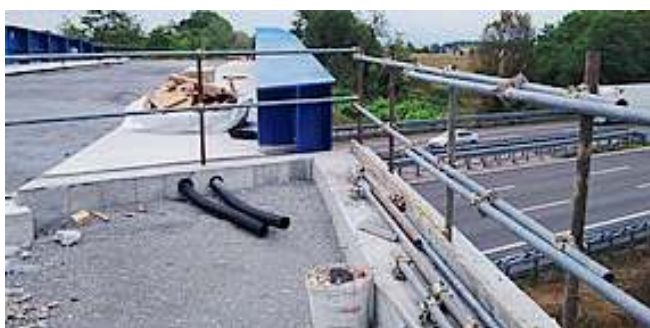
L'opera. Al via la posa della guaina
